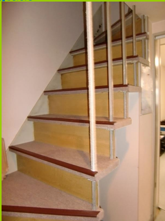
【廊下 & 階段】before
